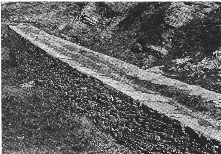
Fig. 20 Il VIADOTTO presso la Ca' de Mucia, probabilmente romano. Visto da sud. Piano: C.
